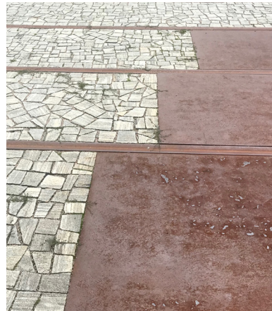
Stenbelægning og stål
